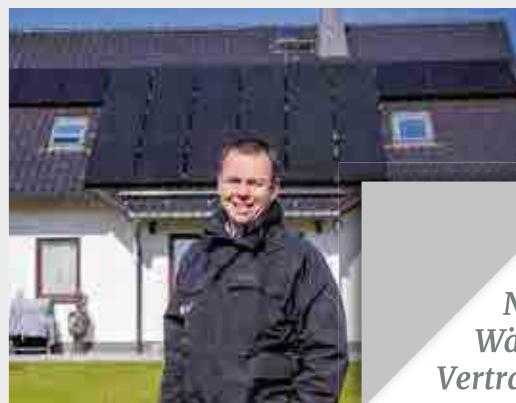
Eine PV-Anlage in Großbrückerswalde
